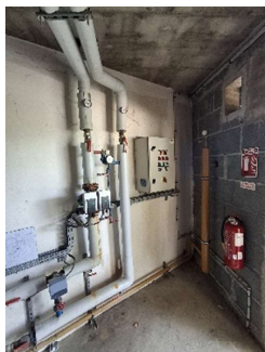
Armoire électrique et pompe double
